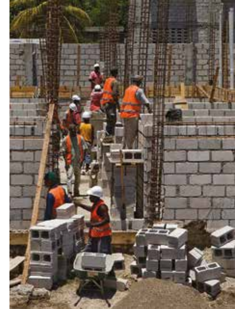
Construction d'une nouvelle prison en Haïti
